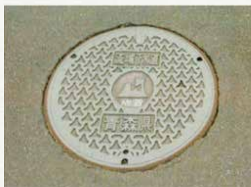
流域下水道マンホール
