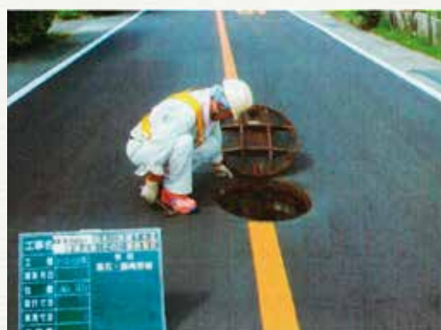
マンホール点検作業風景
