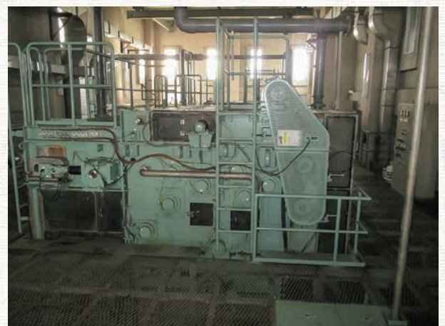
ベルトプレス脱水機
