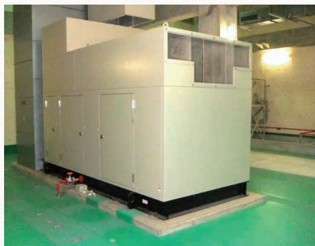
ガスタービン発電機
