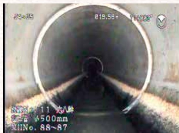
下水管の調査画像 (塩化ビニル管φ500mm)
