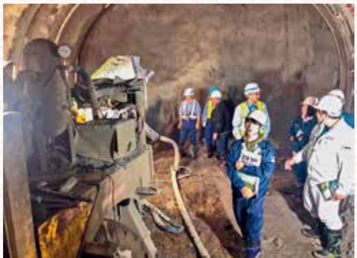
写真-9 トンネル工事現場の切羽で、工事方法、建設機械などの説明を受ける。高い関心を受けた見学でした。
