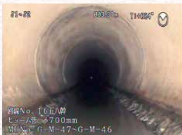
下水管の調査画像 (鉄筋コンクリート管φ700mm)
