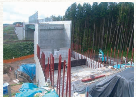
吹越跨線橋背後の軽量盛土工
