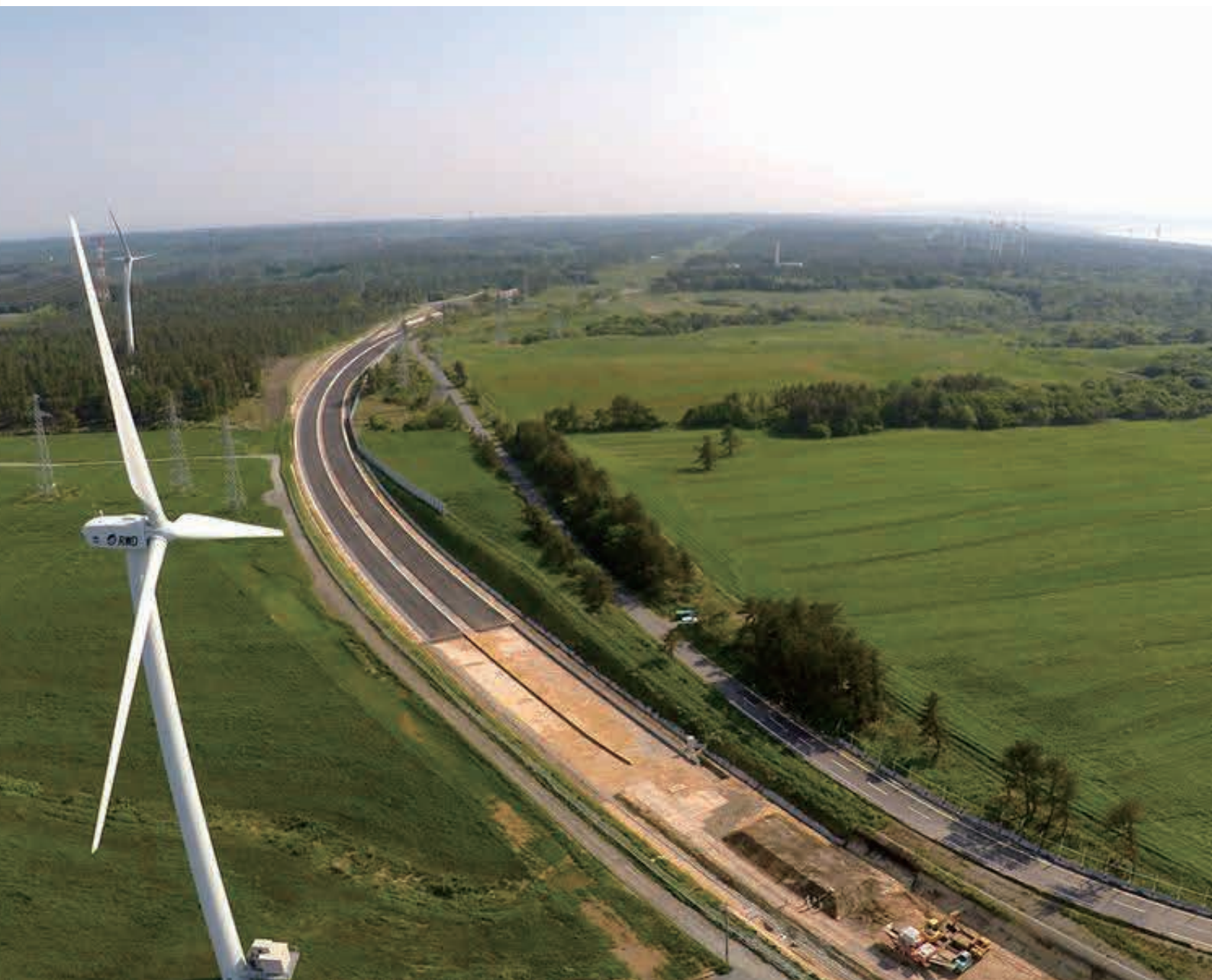
延伸工事が進む下北半島縦貫道路(吹越工区)
