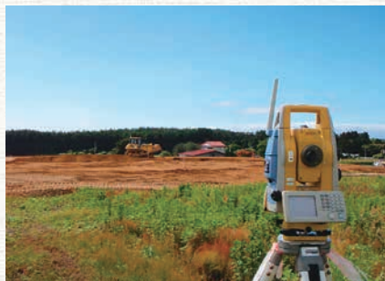
TSによる盛土締固め管理状況
