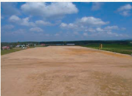
起点部の路体盛土施工状況
