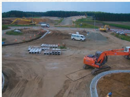
Eランプ町道交差部分の施工状況
