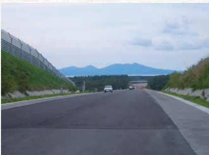
防雪柵設置工事と遠方の釜臥山
