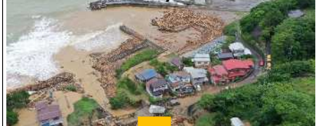
甲海岸 船揚場 流木撤去完了 (8/21)
