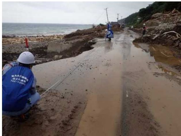
道路の被災状況調査 (風間浦村国道279号)
