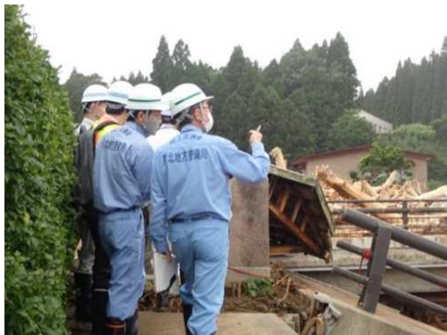
橋梁の被災状況調査 (むつ市小赤川橋)
