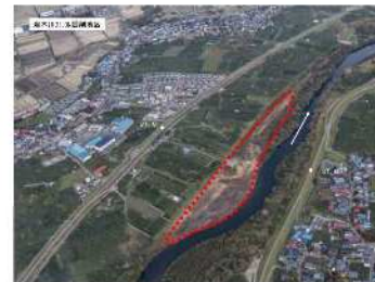
岩木川31km左岸付近の河道掘削
