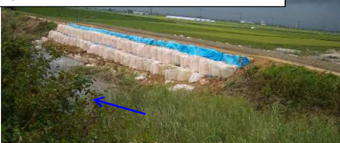
③ 応急仮締切 完了 8月23日
