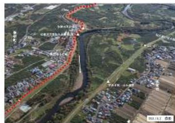
いたやなぎ 岩木川右岸の板柳地区の堤防整備 （着工平成11年／完成平成25年）
