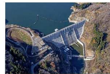
つがる なかつがるぐんにしめやむら 津軽ダム／中津軽郡西目屋村 （着工平成3年／完成平成28年）
