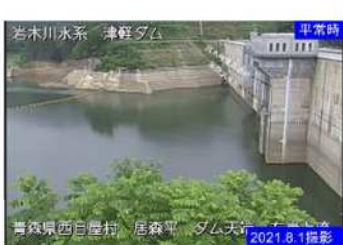
▲平常時の津軽ダム (CCTV)
