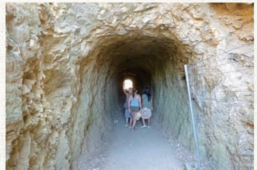
図-4 橋上部の水路につながっている暗渠。大きな断面。工事兼用か。
