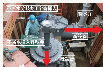
1工区分岐、弁設置
