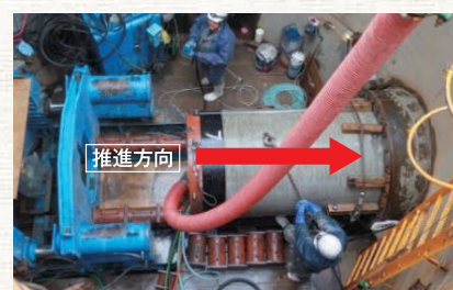
2～3号立坑推進状況(ヒューム管径1100mm)
