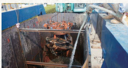
4号立坑掘削・ケーシング設置
