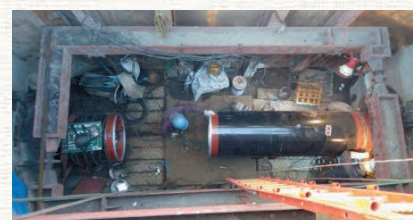
管布設状況(4号立坑内)
