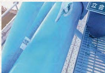
風通しのよい水管橋（錆なし）
