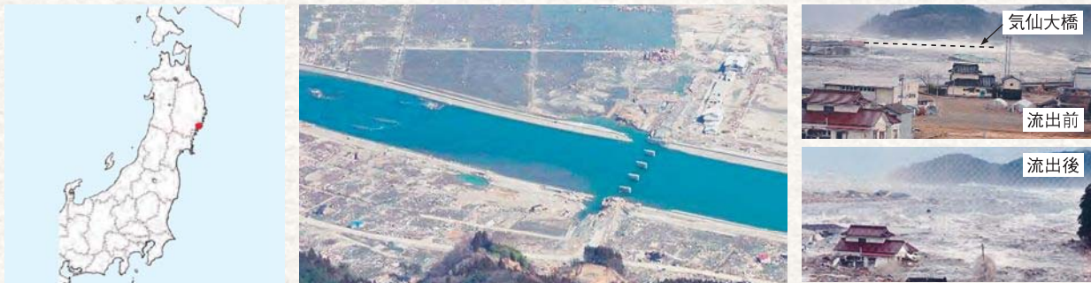
図-1 気仙大橋被災状況（左から、位置、流出状況、津波襲来時）
