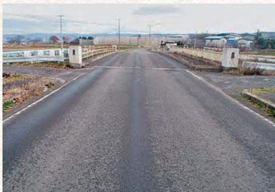
黒石市道 野際赤坂線 赤坂橋（補修前）
