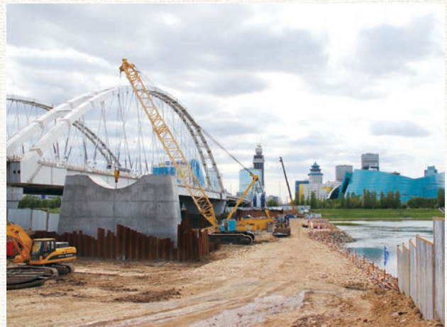
図-7 LRTイシム川橋梁。 既存の道路橋、水管橋に併設して建設中。 アーチリブは、箱形断面の鋼リブ。
