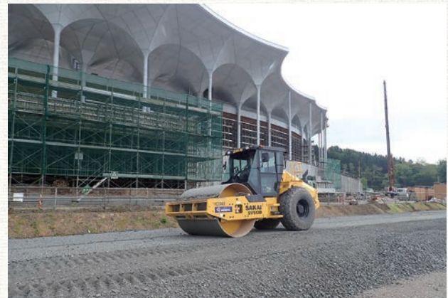
整備状況(駐車場)
