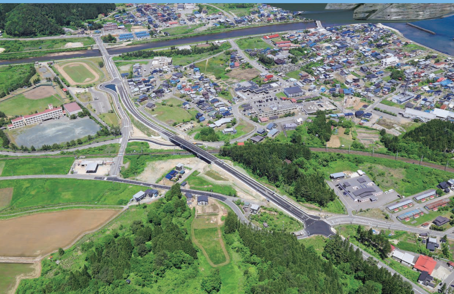
国道280号道路改築工事(外ヶ浜町)
